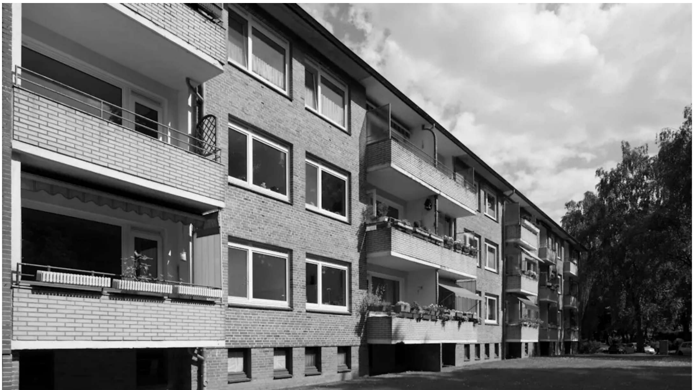
Bestandsbauten im Luthergrund
