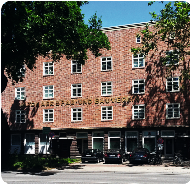
Fassade Bahrenfelder Chaussee nach der Sanierung (Foto: Kristina Wedekind)
