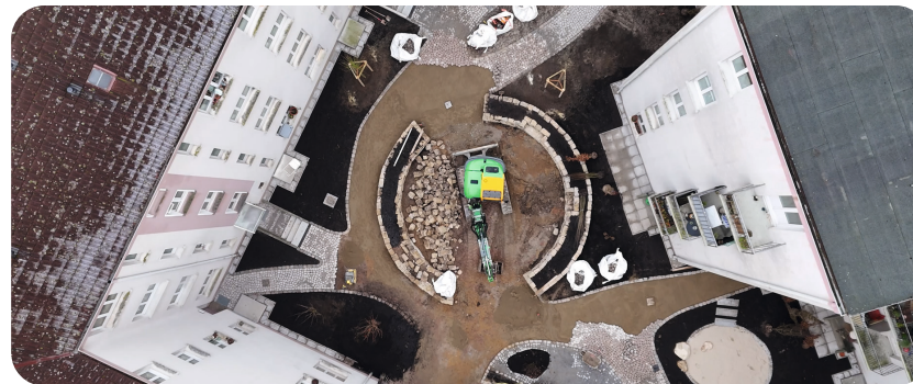
Innenhof Vereinsblock während der Neugestaltung (Drohnenaufnahme: noa4)
