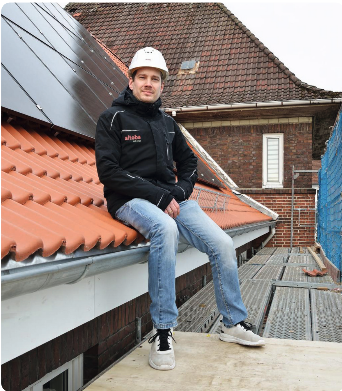
Dirk Laug, Mitarbeiter der Technik, koordiniert die Dachsanierung und Installation von Fotovoltaik im Röhrigblock. (Foto: Kristina Wedekind)
