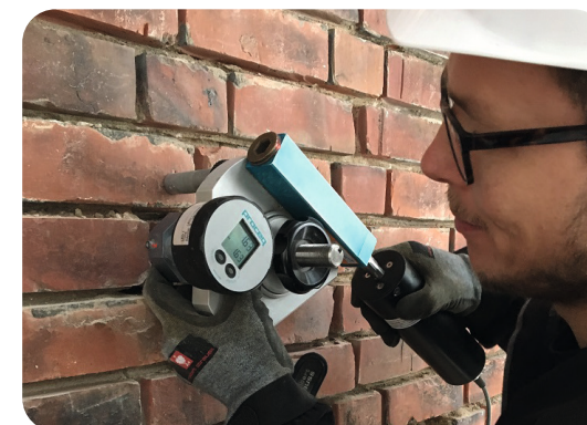
Am Anfang der Fassadensanierungen standen umfangreiche Voruntersuchungen. (Foto: GSPart)
