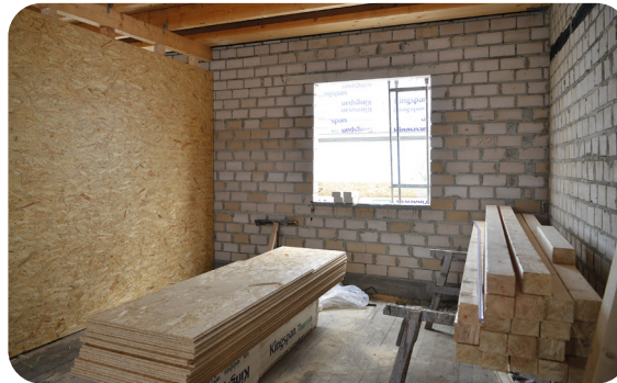
Ausbau der Dachgeschoss-Wohnungen (Foto: Kristina Wedekind)
