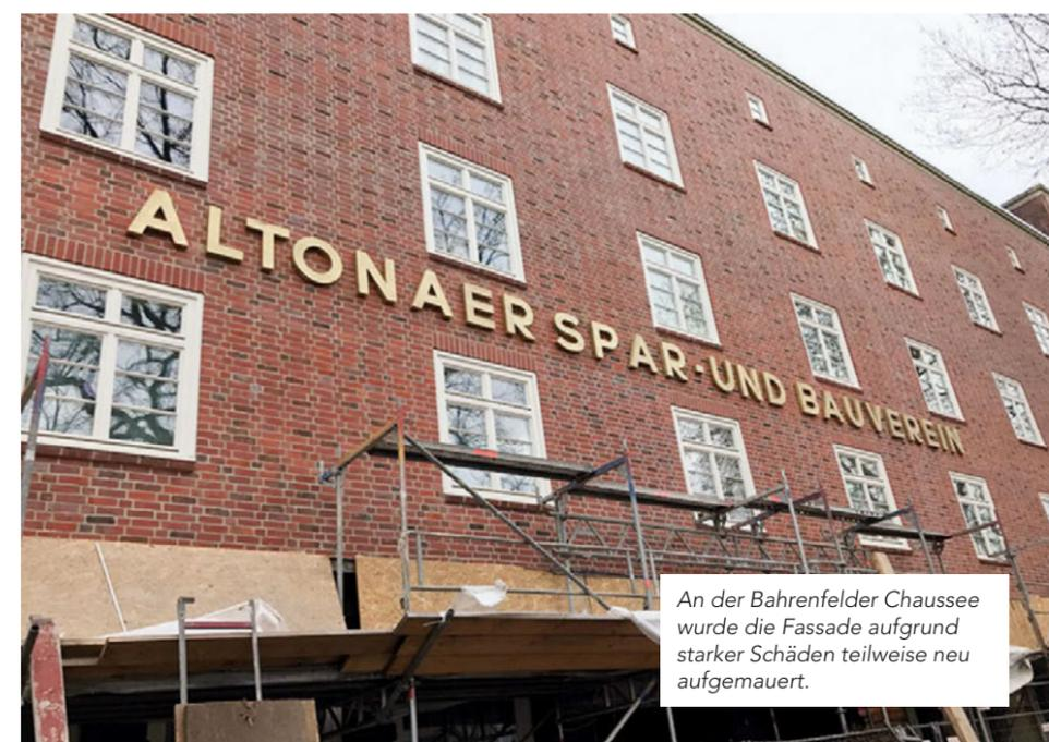
An der Bahrenfelder Chaussee wurde die Fassade aufgrund starker Schäden teilweise neu aufgemauert.
