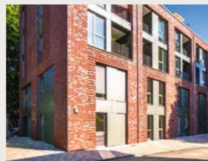
Die Nordseite von Baufeld S07 in den Kolbenhöfen (siehe S. 3); Unterhalb der Ebene mit den Loggien zieht die Kita Käptn Kaninchen ein.
