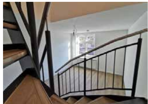
Eine Stahltreppe verbindet beide Ebenen der neu geschaffenen Wohnungen im Dachgeschoss
