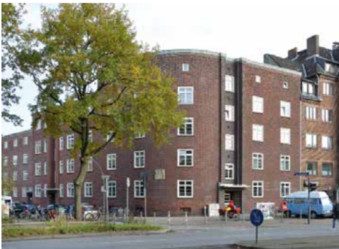
Der Reichardtblock entstand als erste Wohnanlage der Genossenschaft im Stil der neuen Sachlichkeit
