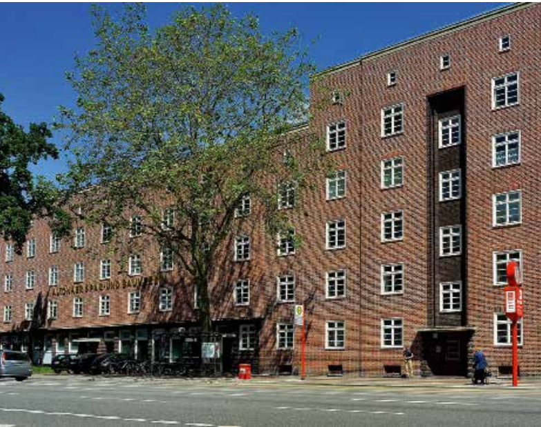
Die Sichtfassade an der Bahrenfelder Chaussee nach dem Wiederaufmauern
