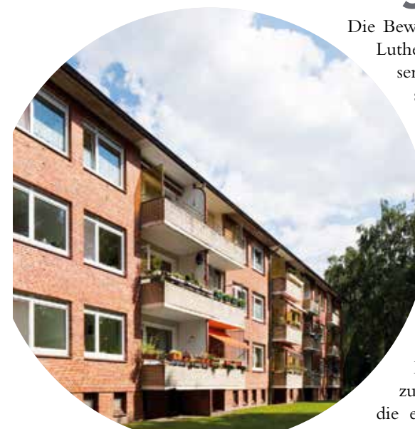
Blick in den Luthergrund
