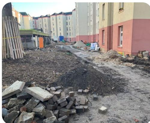
Auch 2022 setzte die altoba die Sanierung der Sielleitungen in ihrem Bestand fort. Aufgabe ist es, gemäß dem Hamburgischen Abwassergesetz die Dichtigkeit aller Entwässerungsanlagen im gesamten Bestand nachzuweisen bzw. bei Bedarf herzustellen. Im Gerichtsblock, im Goldbachblock und im Röhrigblock ist die Sanierung der Abwasserleitungen überstanden. Die Sielsanierung in der Straße Leverkusienstieg ist ebenfalls bereits abgeschlossen.
