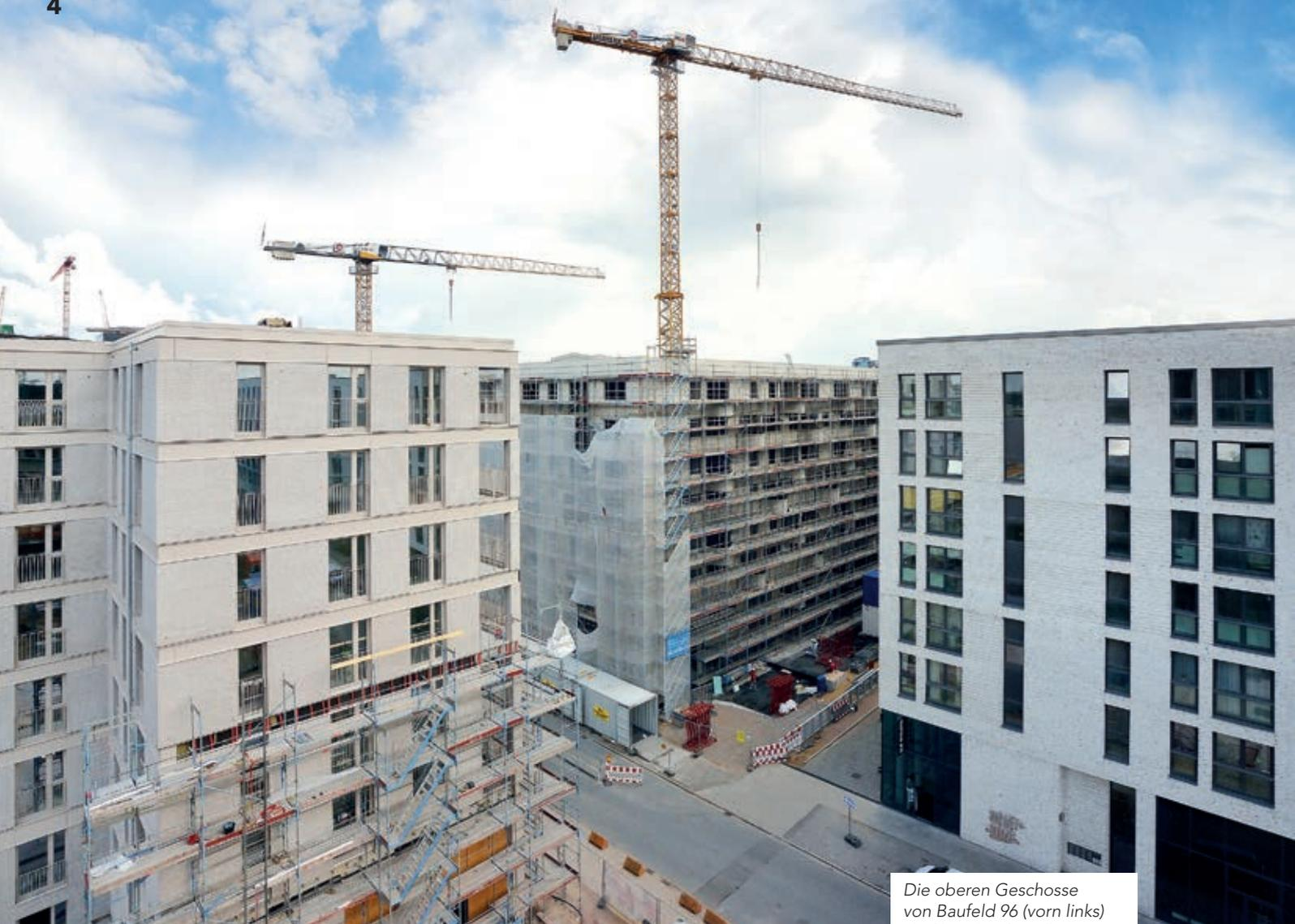
Die oberen Geschosse von Baufeld 96 (vorn links) sind bereits abgerüstet. Auf Baufeld 97 (hinten links) ist es noch nicht so weit.
