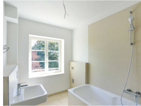
Oben: eines der sichtbar in die Jahre gekommenen Bäder Unten: Beispiel-Bad aus einer der bereits 45 neu geschaffenen Wohnungen im Dachgeschoss
