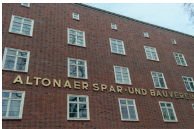
Wiederhergestellte Fassade an der Bahrenfelder Chaussee
