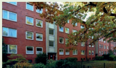
Die Wohnanlage vor der Modernisierung
